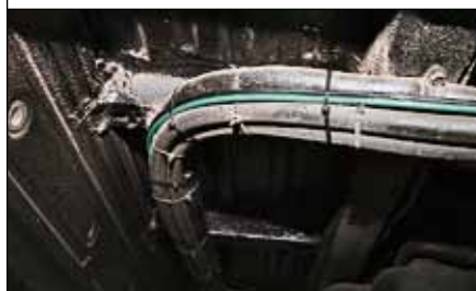
К имеющемуся пучку трубопроводов крепят трубки пневмоподвески
