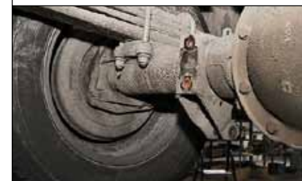
Установка полупневматики занимает не более двух-трех часов
